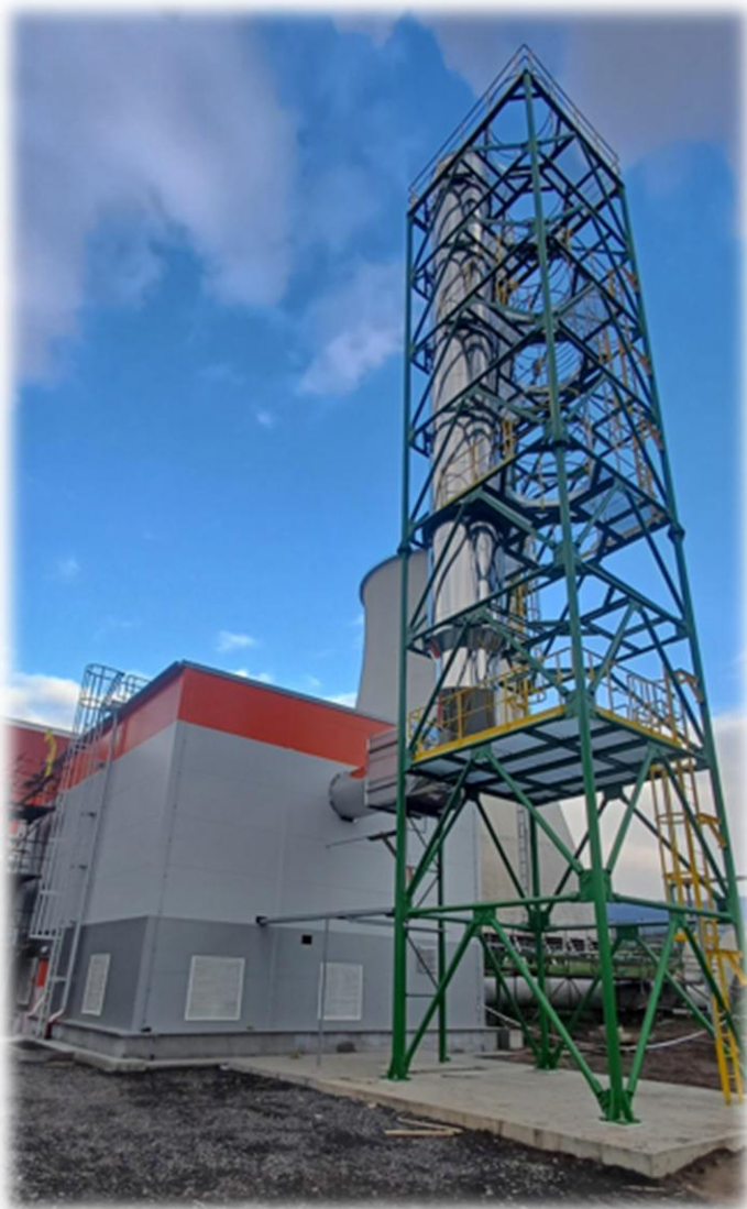
Budova kotelny a 24 metrů vysoký komín pro odvod spalin z kotle
