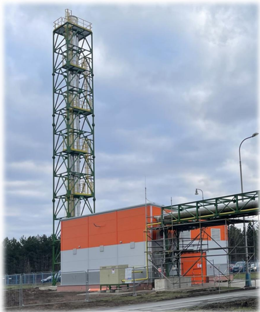
Budova plynové kotelny a dominantní 32 metrů komín www.cezescoc.cz
