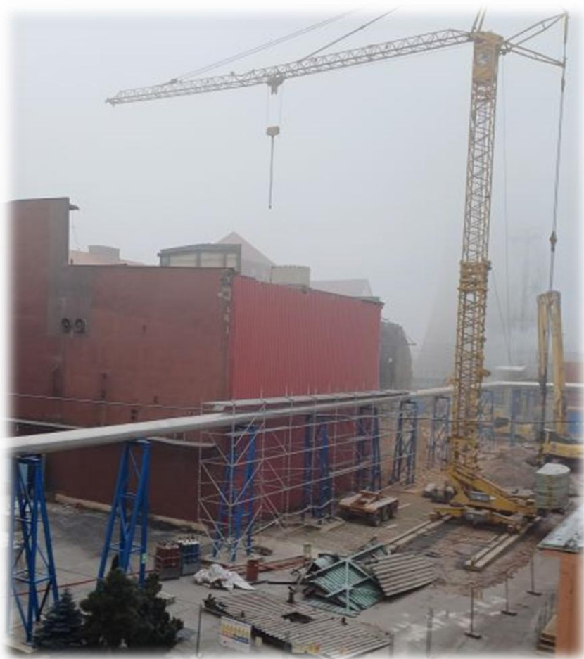
Realizace přeložek a potrubních mostů
