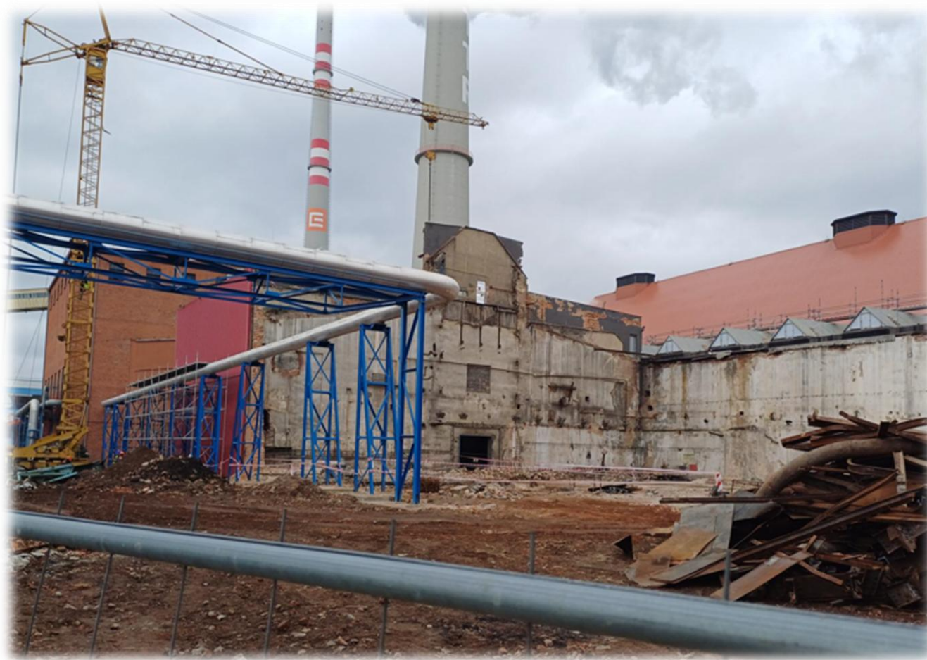
Demolice, přeložky a potrubní mosty
