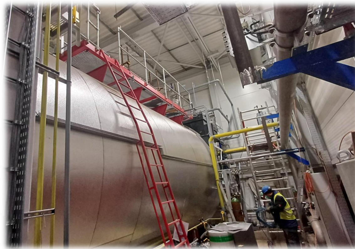
Pohled do kotelny
